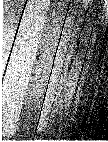
PLAQUES ONDULEES EN AMIANTE CIMENT PRESENTES LOCALEMENT EN TOITURE. CF CROQUIS POUR LA LOCALISATION.
